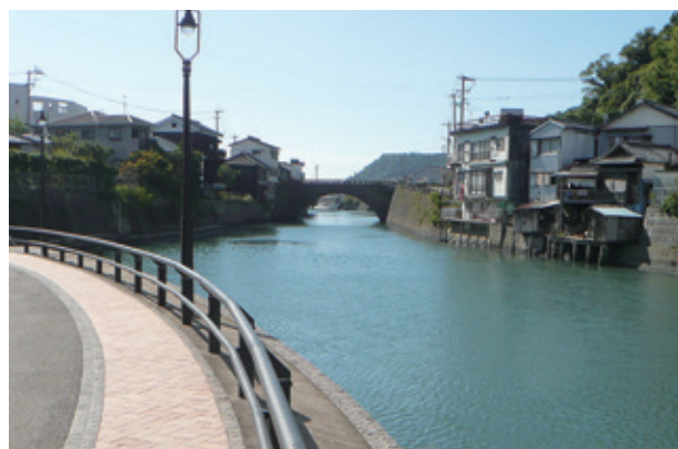
写真5：現在の堀川運河
