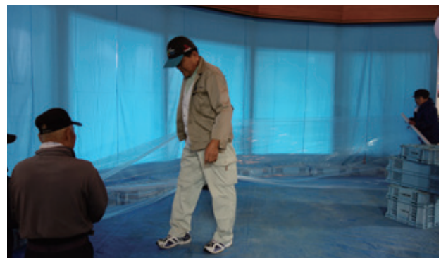
図14 防水等のためにビニルシートをかける作業 (2018年3月筆者撮影)
