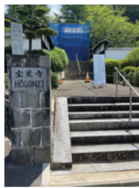
山門修理の現場
