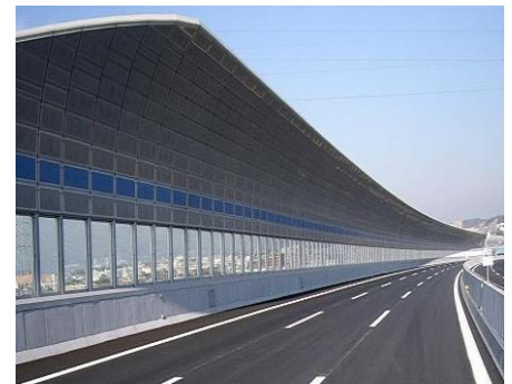
図1 高速道路の防音壁
