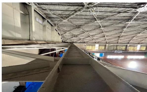
図2 耐震補強に用られているH鋼
