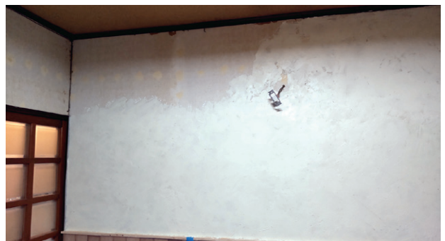
図5 (左) 壁紙を剥がした壁塗り前 (右) 壁塗り後 (塗料不足により中断)
