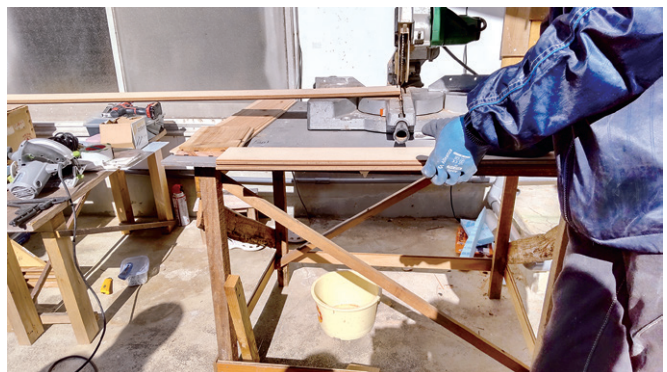
図8 デッドストックの床板を設置型丸鋸で切断した
