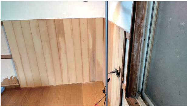
図9 切り揃えた床板をコンプレッサーで打ち付け、腰板ができた
