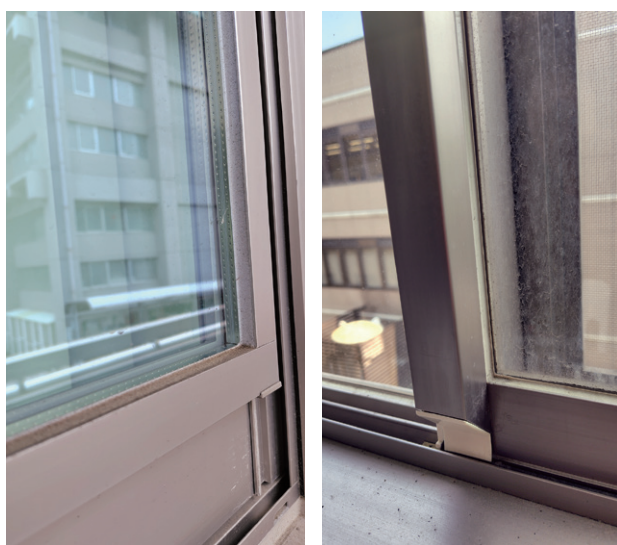
図1 (左) 愛媛大学内のグリーンホールの窓ガラス (右) 研究室の窓ガラス
