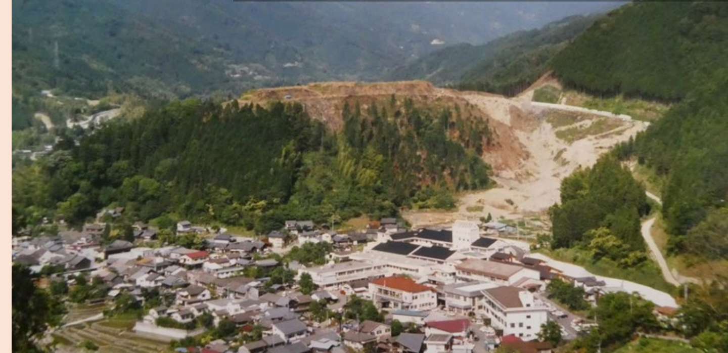
城の台公園造営工事を終え、 滅失する前の太田城
