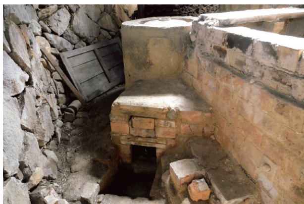
写真4 楽焼窯 (左 正面 (焚口)、右 焼成室内部 (内窯))
